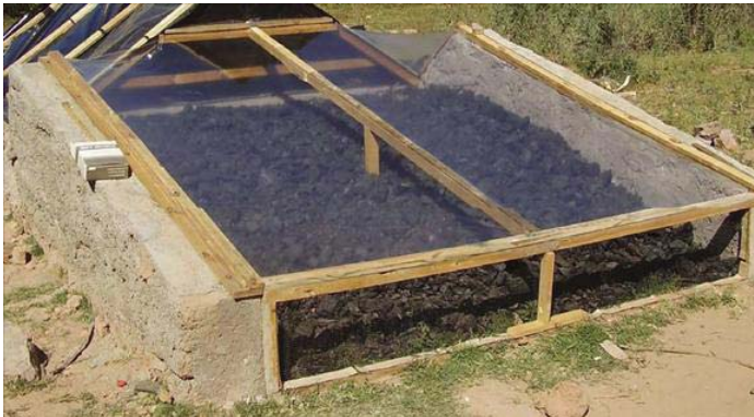
Armado del colector.
