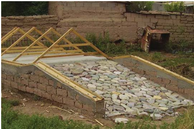
Construcción de la estructura del deshidratador solar.
