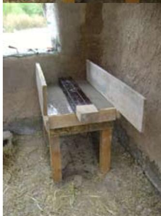
Colocar el molde de la entrada de leña y encima colocar la teja. Situar el molde de la cámara de combustión y del comal. El tamaño de la pieza debe ser igual que el comal a utilizar.
