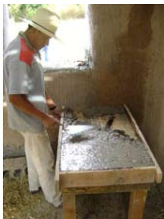
Agregar dos palas llenas de grava, para ayudar a conservar el calor en la estufa. No se recomienda utilizar piedra de río, pues pueden reventar al calentarse. Al extender la grava, hay que procurar que quede despegada unos cinco centímetros del cajón.
