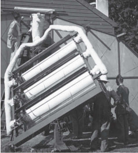
Colector de calor desarrollado por Charles G. Abbot.
